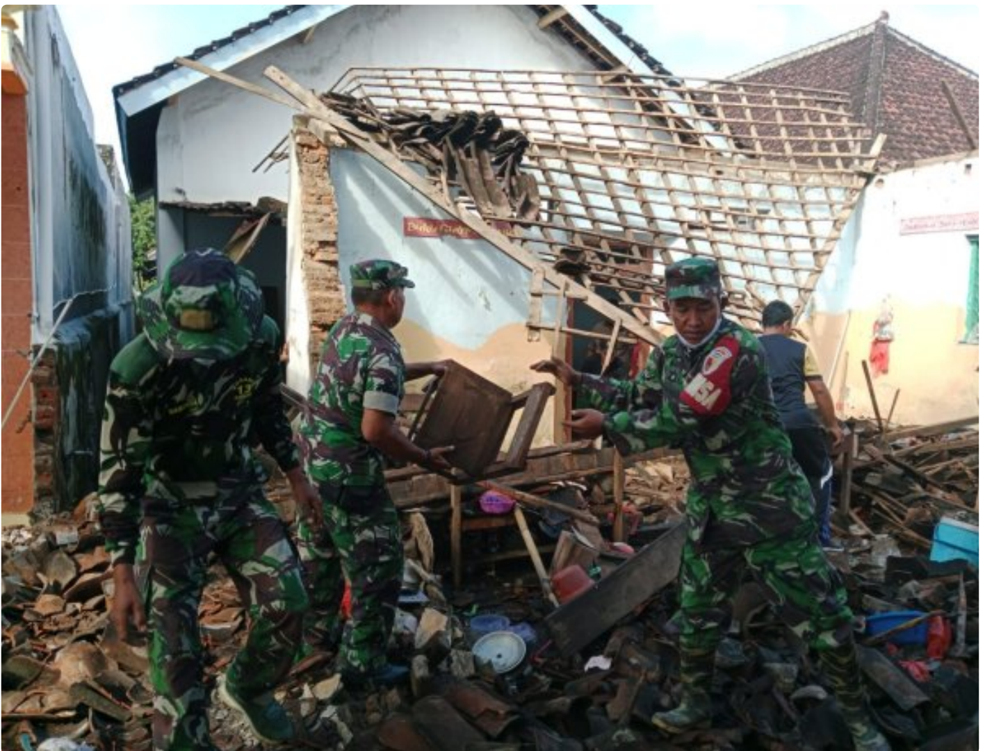
Sinergi TNI - POLRI dan BPBD Gotong Royong Bersihkan Puing Bagunan Gudang Perlengkapan SDN Bendo 02 Pasca Roboh
