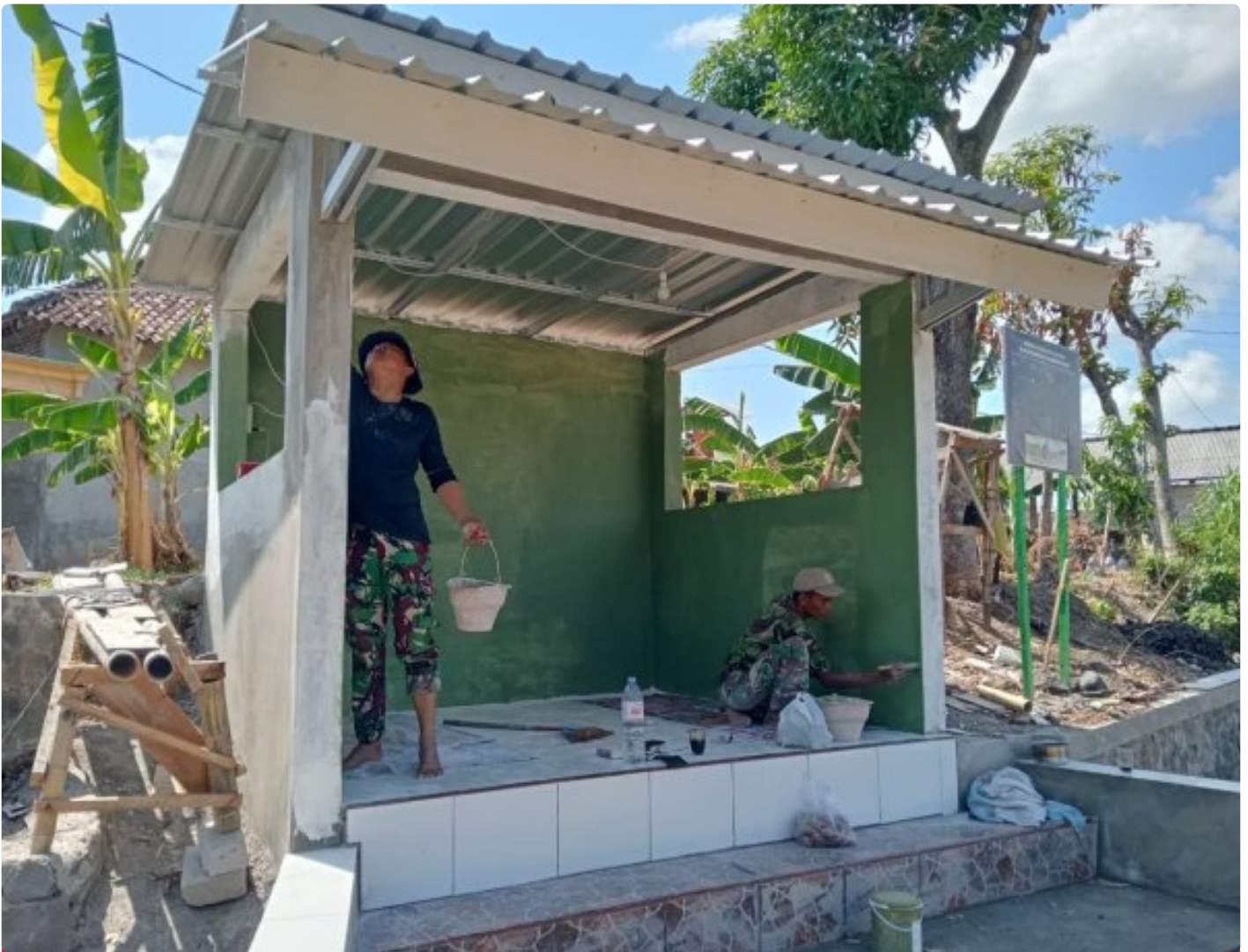
Mengintip Pembangunan Poskamling di Lokasi TMMD ke-126 Desa Kembangan
